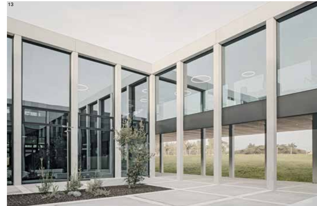
11, 12 viste dei portici, nelle quali si evince la differenza tra gli elementi strutturali in cemento armato grigio chiaro e le parti non strutturali – gli infissi in alluminio anodizzato e i rivestimenti in listelli di cotto- scure 13, 14, 15 viste della corte interna, aperta sul fronte orientale, e del ponte che richiude l'edificio al primo piano
