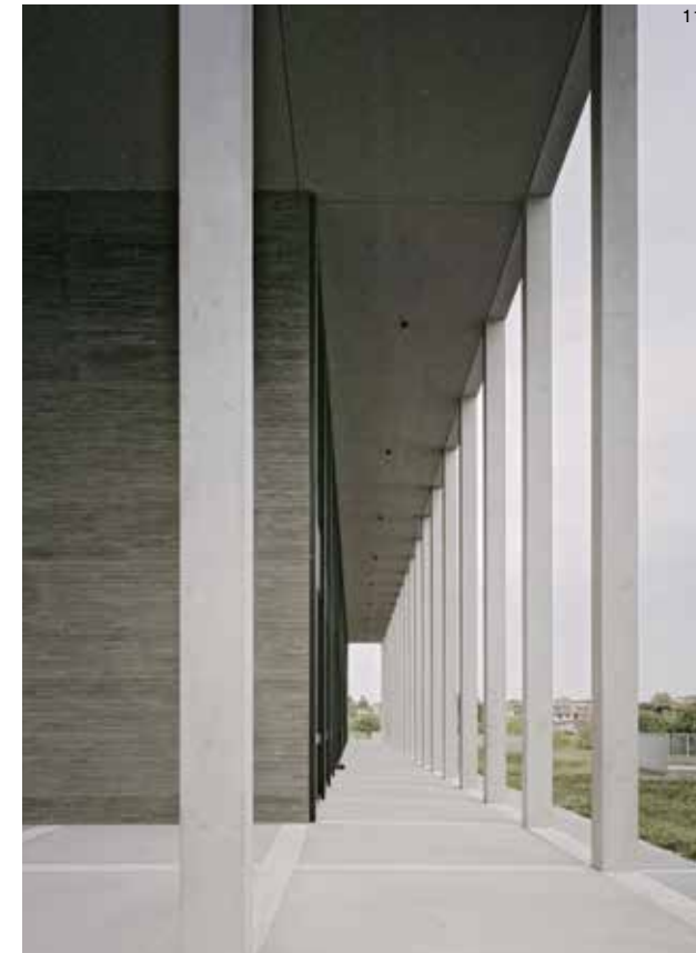
11, 12 viste dei portici, nelle quali si evince la differenza tra gli elementi strutturali in cemento armato grigio chiaro e le parti non strutturali – gli infissi in alluminio anodizzato e i rivestimenti in listelli di cotto- scure 13, 14, 15 viste della corte interna, aperta sul fronte orientale, e del ponte che richiude l'edificio al primo piano
